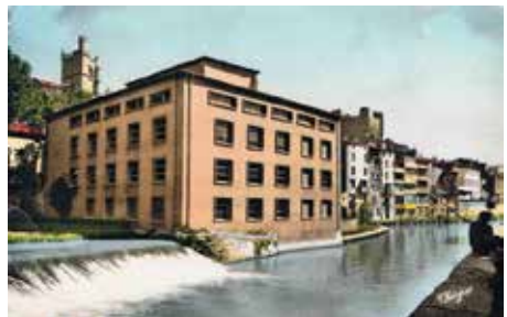
Médiathèque du Grand Narbonne CP
